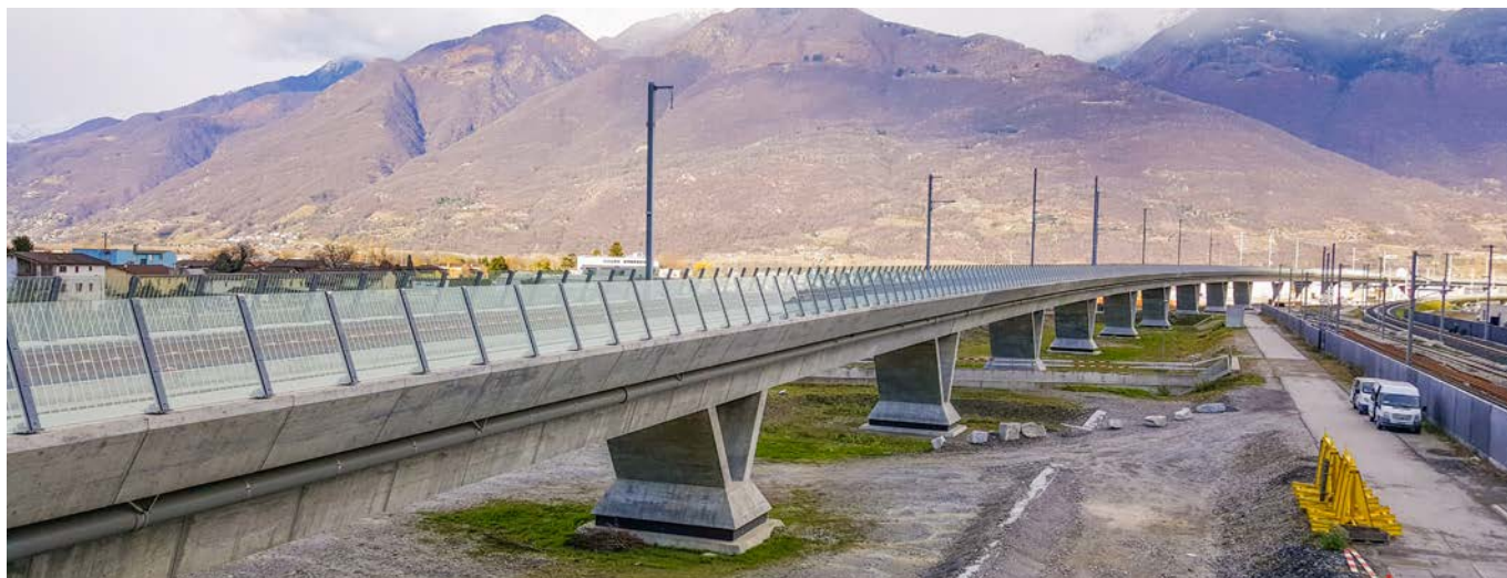
Nach der Inbetriebnahme des neuen Ceneri-Basistunnels Ende 2020 (im Bild das Viadukt vor dem Portal zur Weströhre in Camorino) wird die alte Ceneri-Strecke für den Regionalverkehr genutzt.
