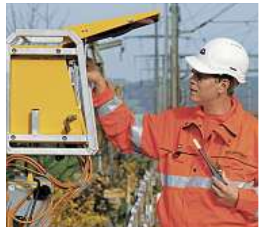
Am Morgen ist der Sicherheitswärter als erster auf der Baustelle. Hier schaltet er das automatische Warnsystem ein. Dieses unterstützt den Sicherheitswärter.
