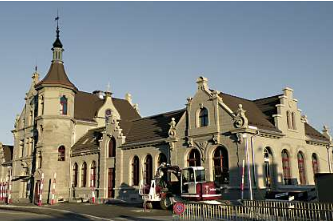
Der 1895 erbaute Bahnhof Rapperswil präsentiert sich nach der Renovation als Bijou. Die Aussenfassade wurde weitgehend in den Originalzustand zurückverwandelt.
