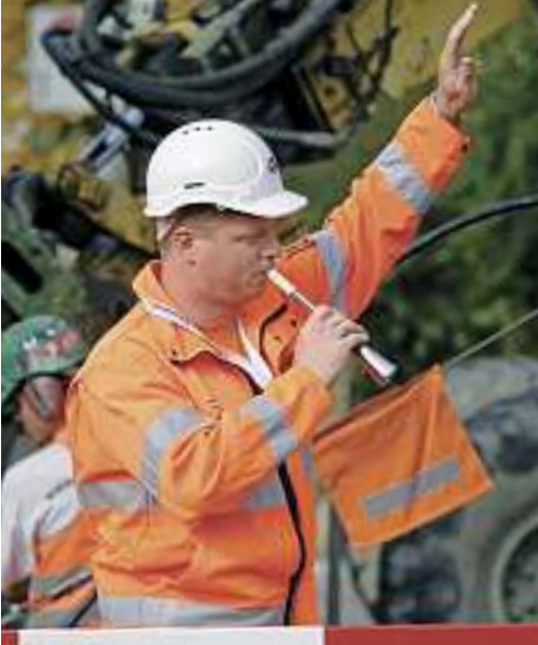
Ein Zug naht. Rechtzeitig bläst der Sicherheitswärter das Signalhorn. 20 bis 60 Sekunden später hat sich die Baugruppe aus dem Gefahrenbereich entfernt.
