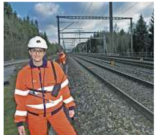
Die Sicherheitswärterin hat die Baustelle jederzeit unter Kontrolle.
