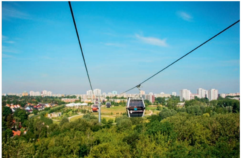
Die für die Internationale Gartenausstellung 2017 in Berlin erstellte Seilbahn wird zukünftig urbane Verkehrsaufgaben übernehmen.
