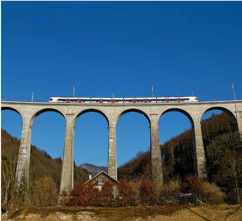
Bald unterwegs über die Grenze: „Flirt France“ (Viadukt von St-Ursanne).
