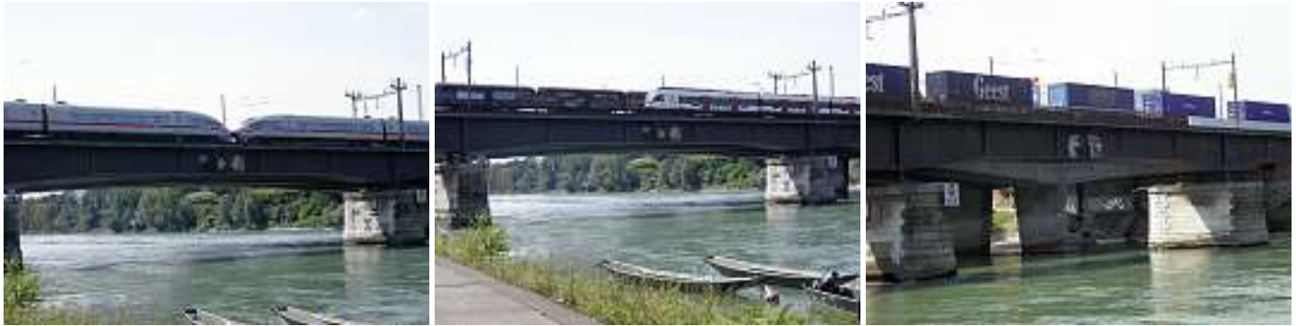
Basler Verbindungsbahn: ICE nach Amsterdam, S-Bahn nach Lörrach und Container nach Gioia Tauro. Alles drängt sich durch dieses Nadelöhr.
