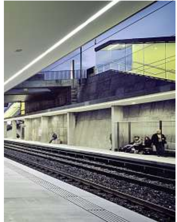
Die neue S-Bahn-Haltestelle Dreispitz.
