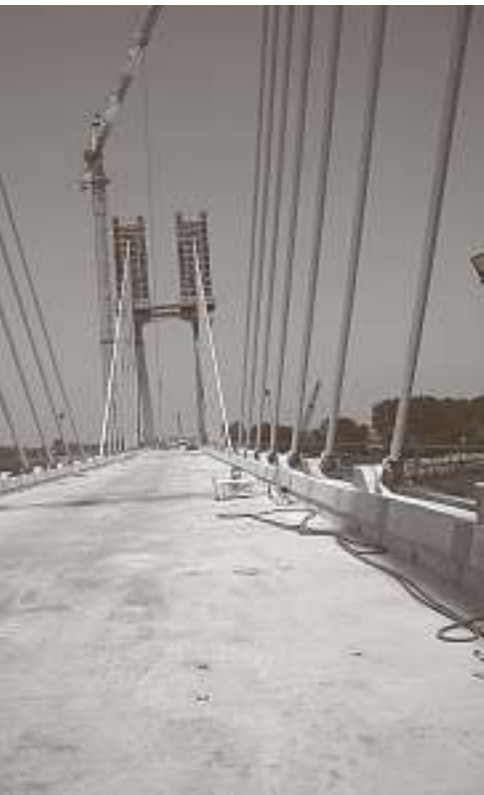
Brückenbau für die Hochgeschwindigkeitslinie über den Fluss Po.
