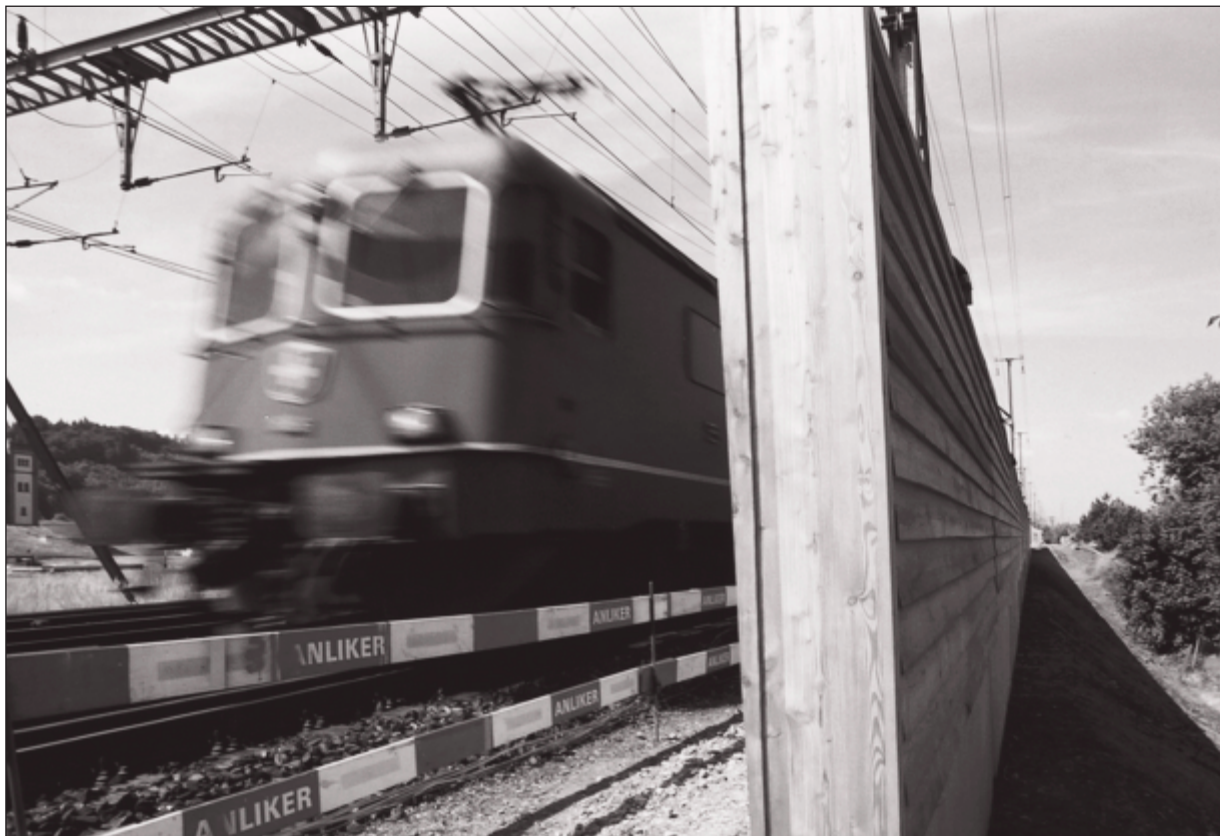
Mehr Bauten für weniger Lärm: Insgesamt sollen entlang der Bahnlinien in der Schweiz 270 Kilometer Lärmschutzwände gebaut werden.
