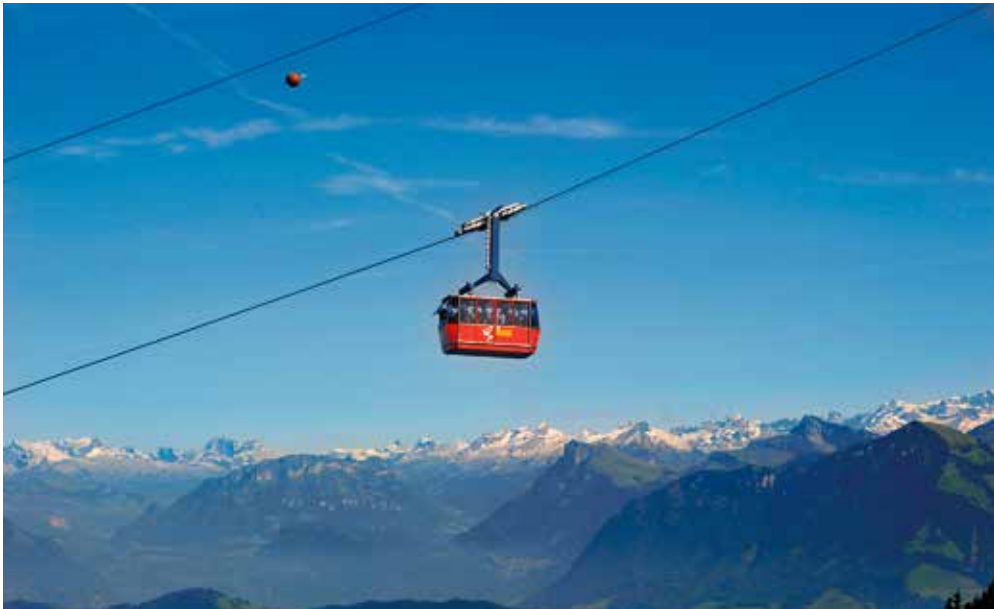
Wird bald ausrangiert und ersetzt: Die Luftseilbahn Fräkmüntegg–Pilatus Kulm.
