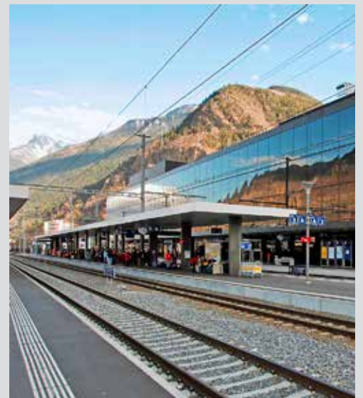
Wo Gefahr lauert: Bahngleise (hier im Bahnhof Visp). Bild: SBB
