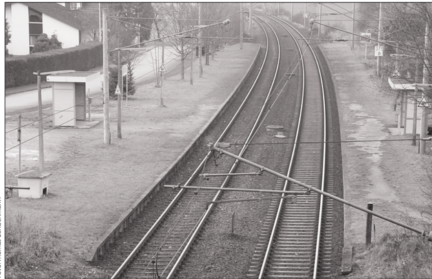
Bestehende Geleise, schlecht genutzt: Beispiel Bietingen.
