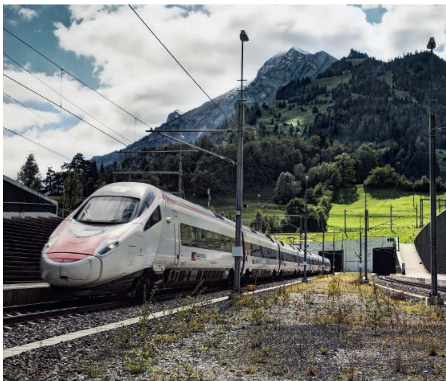
Doppelspur-Ausbau des Teilstücks Ferden–Mitholz nötig: der Lötschberg-Basistunnel (im Bild das Nordportal).
