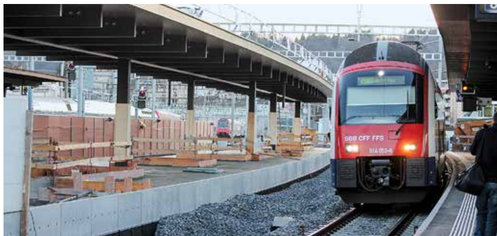
Einfahrt der S7 auf Gleis 8 in Zürich Oerlikon: Das zukünftige Gleis 7 gleicht noch einer Baustelle.
