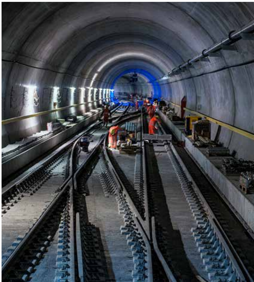
Einbau von Bahntechnik und Beschilderungen im Weinbergtunnel: Höchste Präzision. Bilder: SBB
