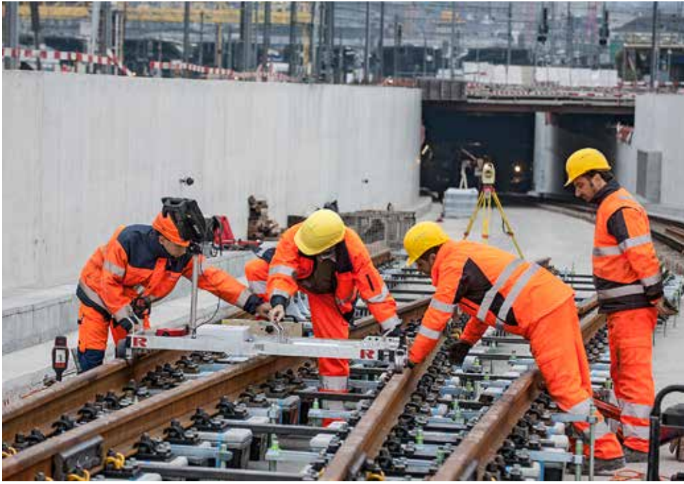
Offene Gleisarbeiten an der DML.
