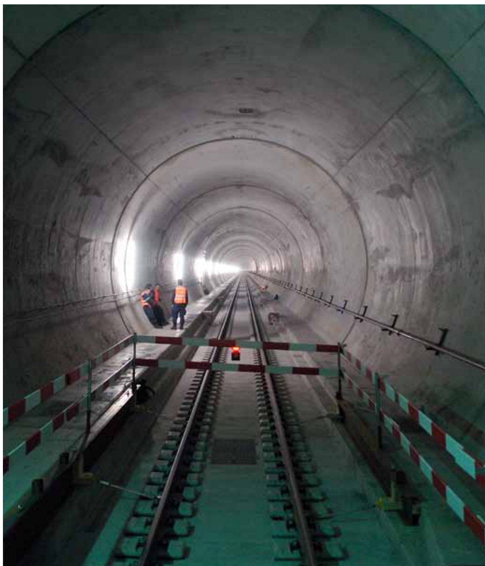
Licht am Ende des Tunnels? Weströhre des neuen Gotthard-Basistunnels bei Bodio.
