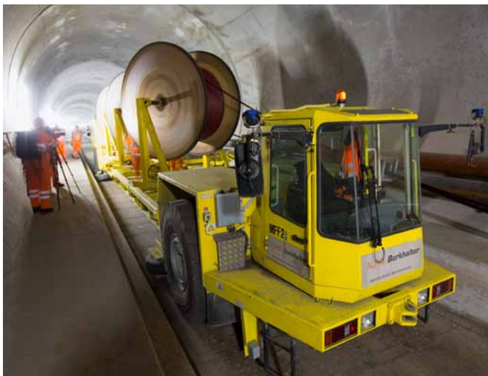
Kabelzug hat Vorrang: Impressionen aus dem neuen Gotthard-Basistunnel.
