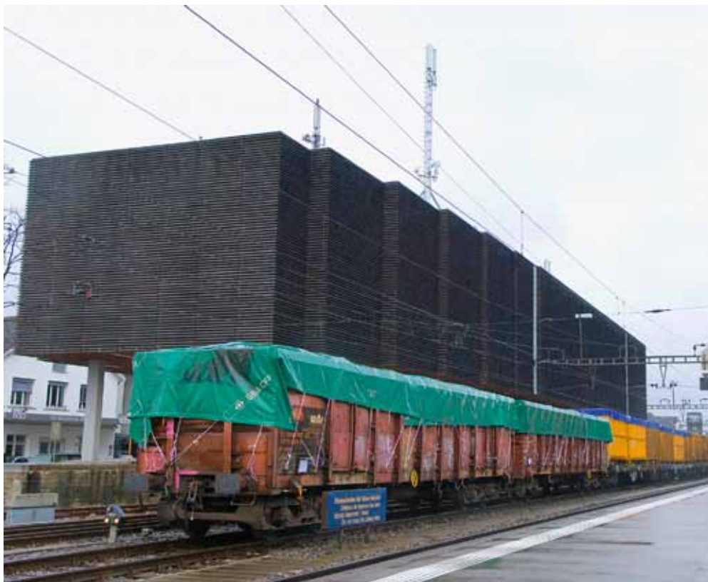
Fortschritte bei der Lärmsanierung: Altpapier-Express in Thalwil.
