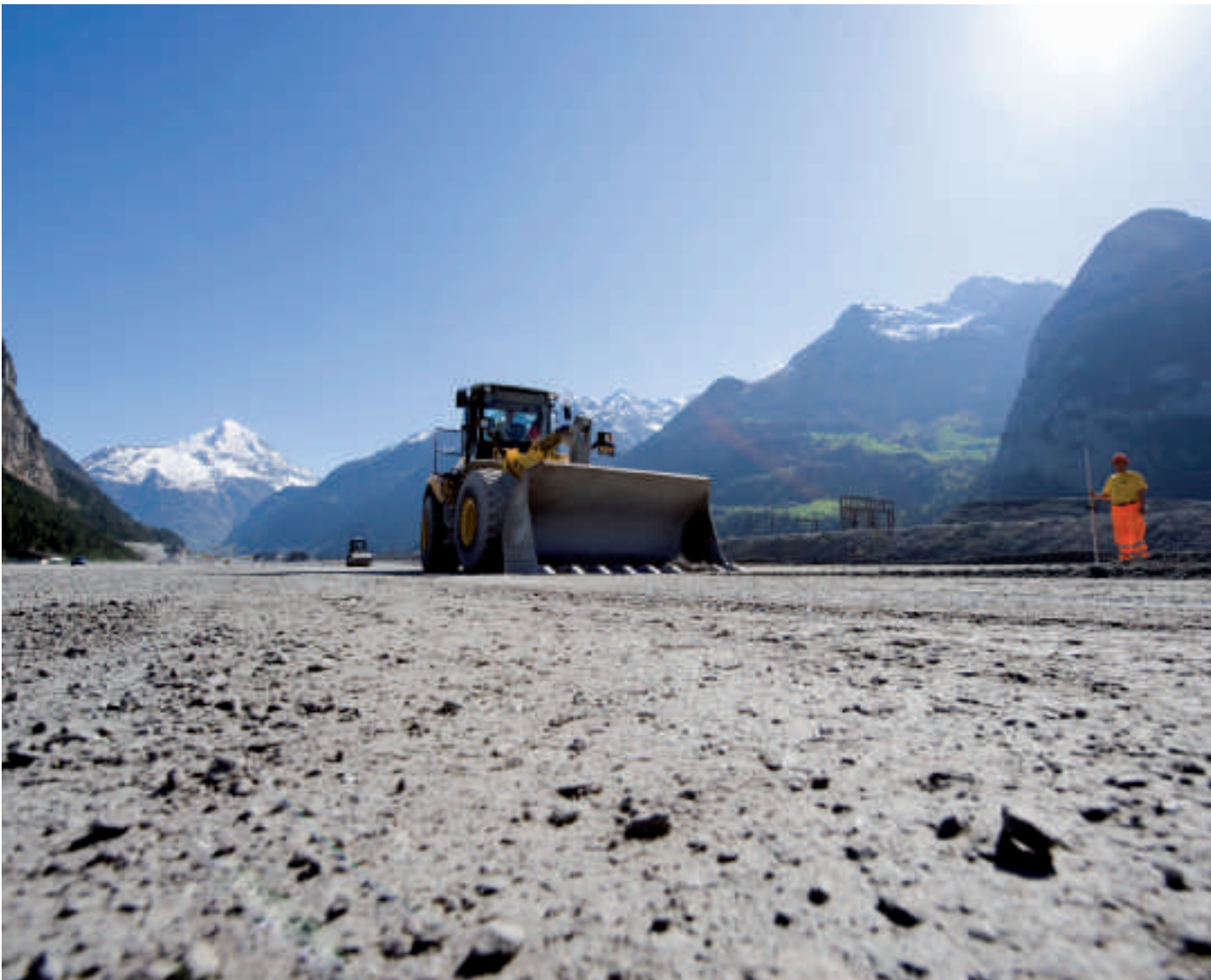
Droht die NEAT das Bahnangebot für Uri plattzuwalzen? Installationsplatz für den Gotthard Basistunnel.
