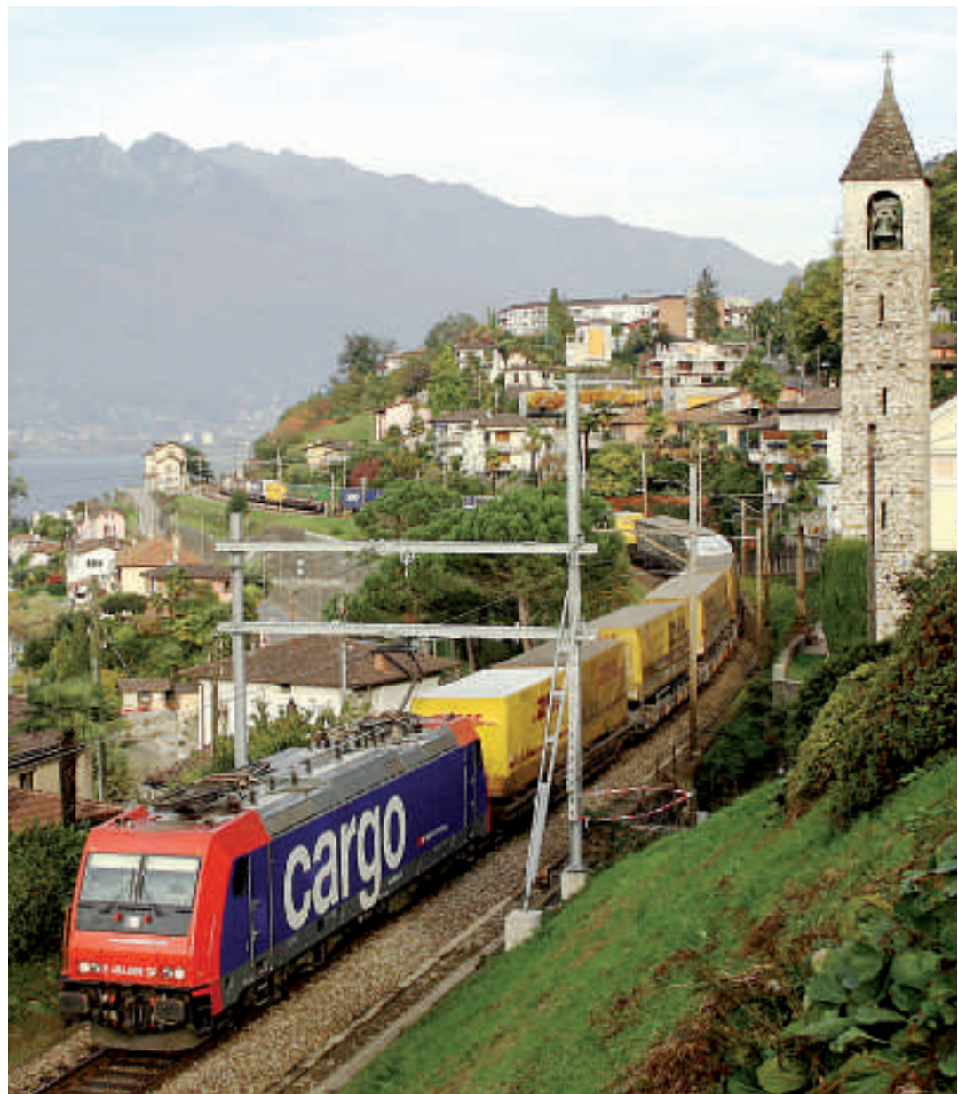
Ausbau dringend Richtung Luino. UKV-Zug von Hupac bei San Nazzaro.
