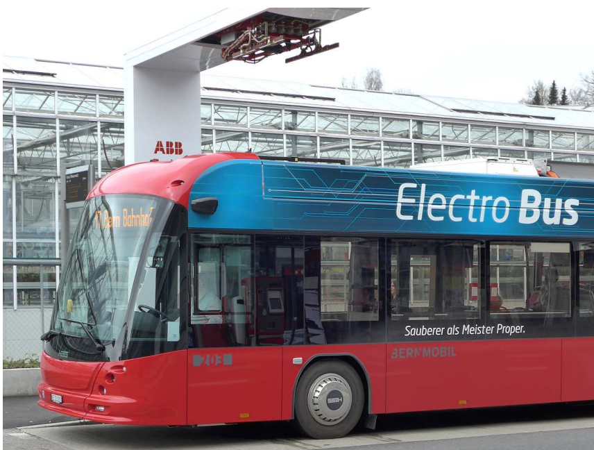
Soeben senkt sich der Stromabgeber der Ladestation in Köniz-Weiermatt zum e-Bus hinunter für das «opportunity charging» von einigen Minuten
