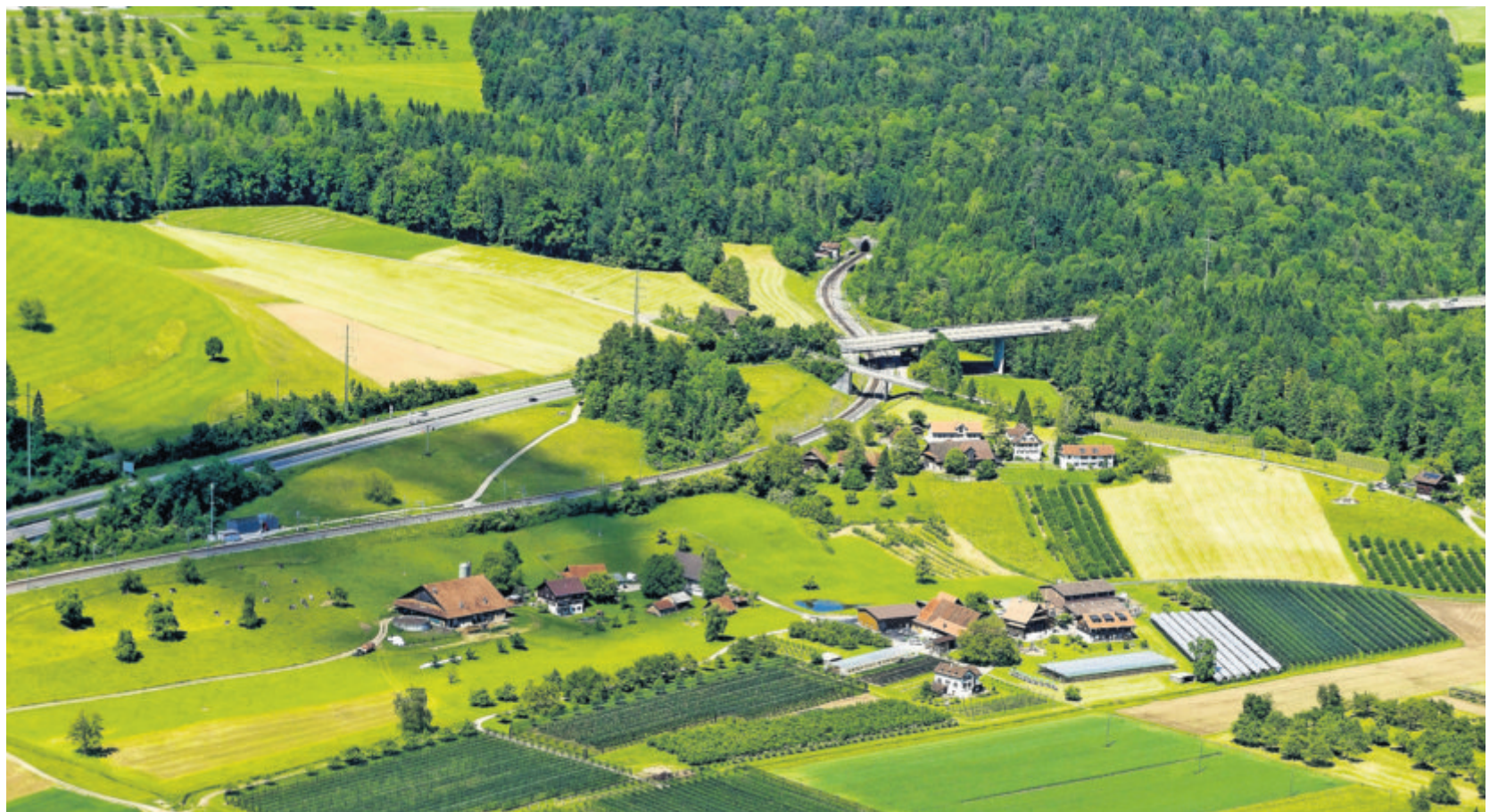
Blick auf das Portal des SBB-Albistunnels im Baarer Gebiet Litti. Der Eingang des geplanten Zimmerberg-Basistunnels käme etwas östlich der heutigen SBB-Strecke mitten im Wald zu stehen. PD
