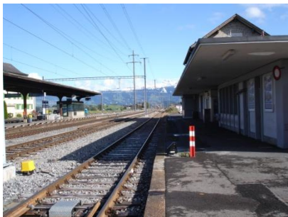
Gleis 1 wird überdeckt
