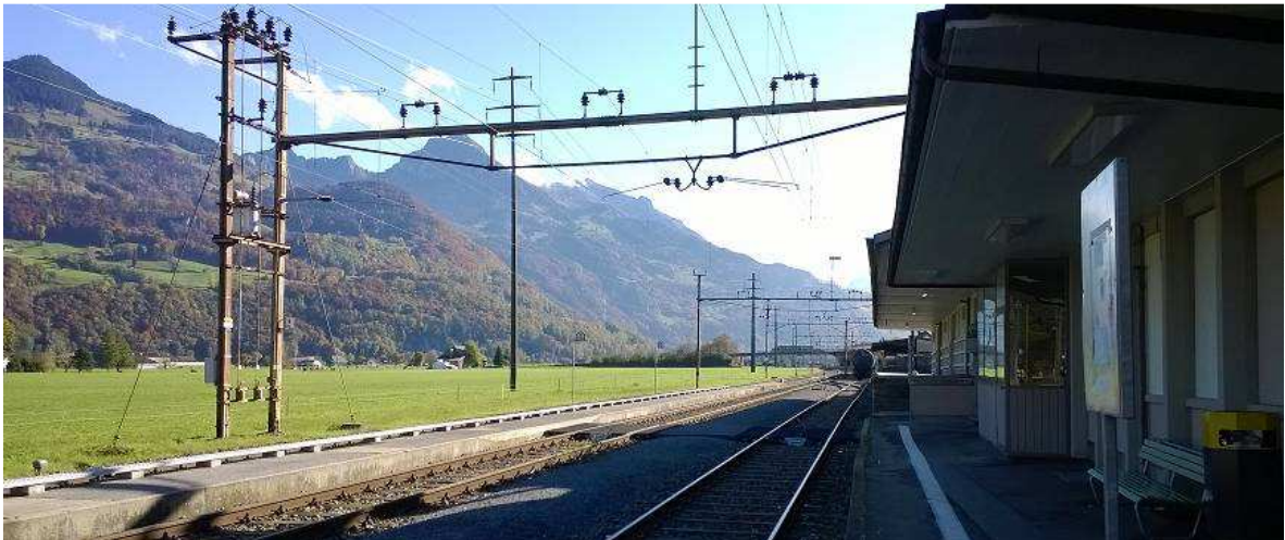
Bahnhof Nieder- und Oberurnen, Publikumsanlagen veraltet und Personen mit Handicap können nur sehr erschwert mit fremder Hilfe den Zug besteigen. Der Umbau dieser Publikumsanlagen ist im Rahmen des Projektes ATR Glarnerland nicht vorgesehen.
