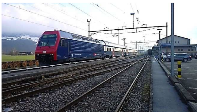
Alte Publikumsanlagen im Bahnhof Nieder- und Oberurnen
