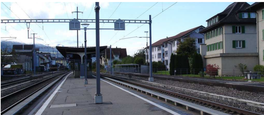
Bahnhof Siebnen, rechte Bildseite > Bahnsteigkante ehemaliges Gleis 5 sichtbar
