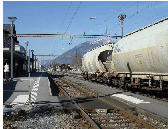
Bahnhof Netstal, da sieht man die Notperronkante und der erneuerte Gleisübergang. Im Verspätungsfalle muss hier anstelle von Glarus gekreuzt werden.
