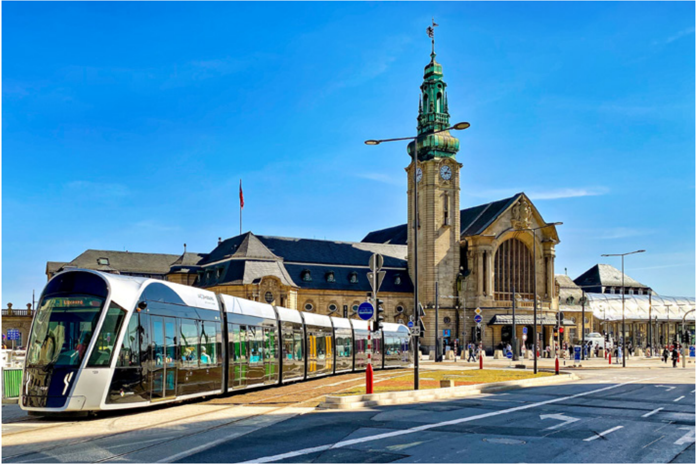
«La Gare de Luxembourg»: Schnittpunkt von Bahn, Tram und Bus. «Le Tram» fährt im Batteriemodus durch die Innenstadt.
