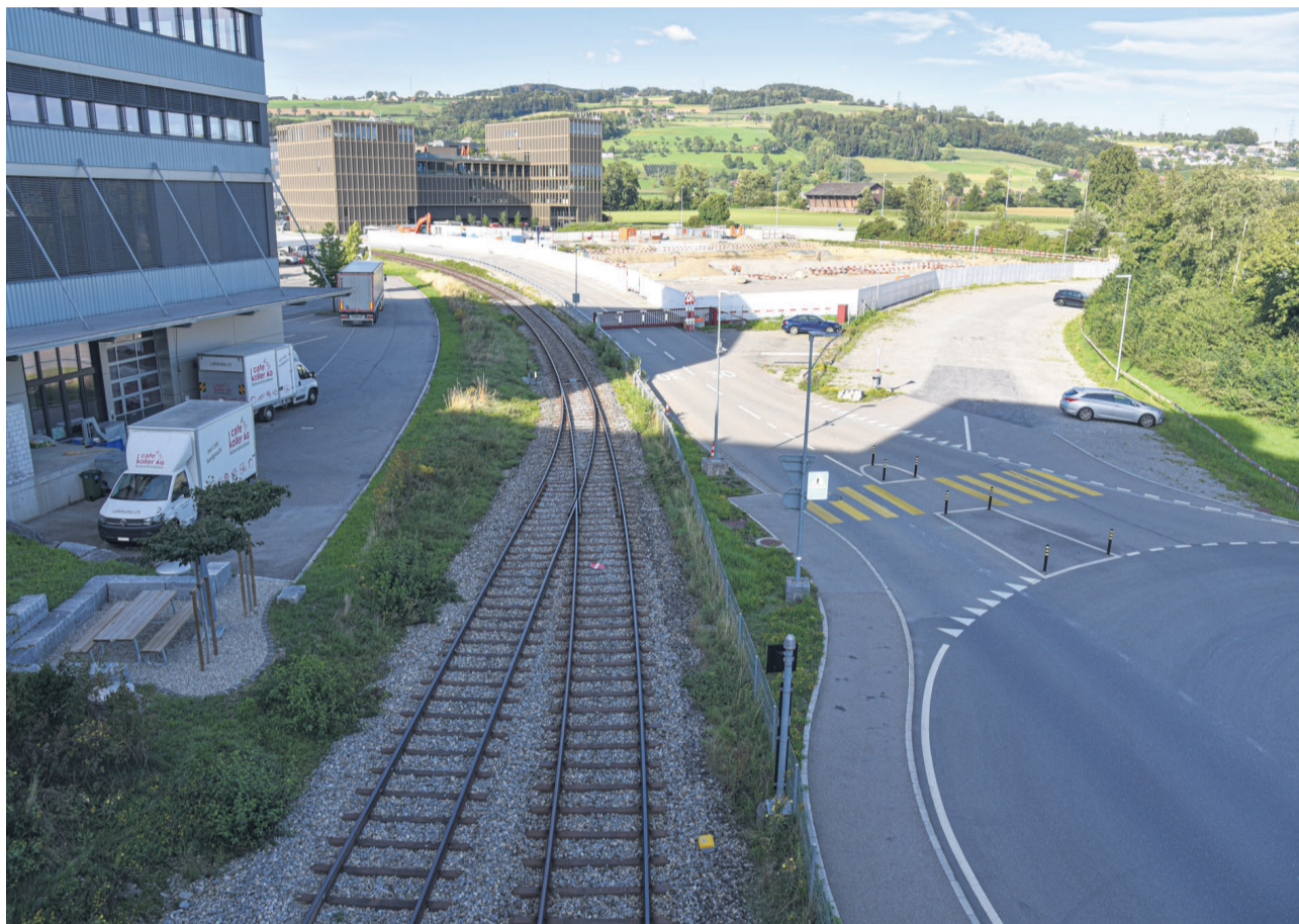
Das Trasse der Sursee-Triengen-Bahn führt nahe am Standort des künftigen Luzerner Kantonsspitals Sursee auf der Schenkoner Schwyzermatt (auf dem Bild hinter der Baustelle zu sehen) vorbei. FOTO FLAVIA RIVOLA
