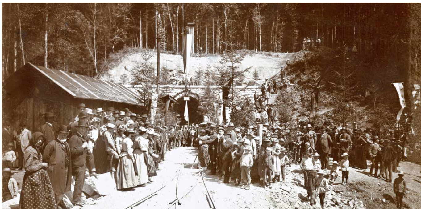
Ein besonderes Augenmerk liegt auf dem Ingenieur Franz Vital Lusser (1849-1927), der auf zahlreichen Bahnstrecken tätig war und als Meisterstück den abgebildeten Albistunnel verwirklichte.
