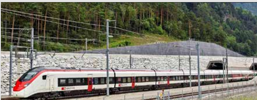
La galleria di base del San Gottardo.
