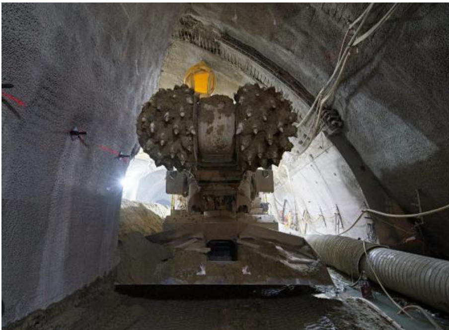
Teilschnitt-Maschine für bergmännischen Vortrieb.
