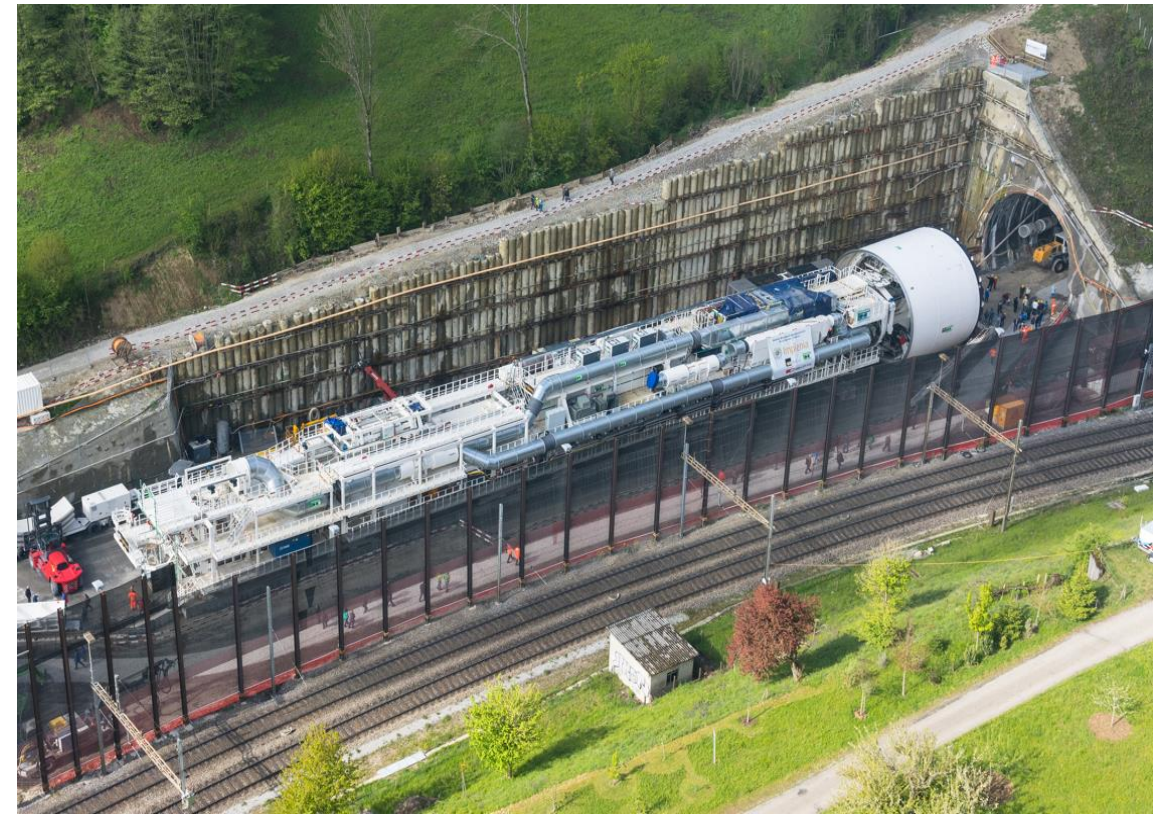
Tunnelbohrmaschine, Beispiel Bötzbühl Tunnel
