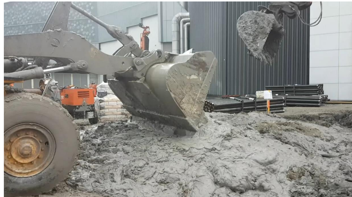
Anspruchsvoller Baugrund in Luzern.
