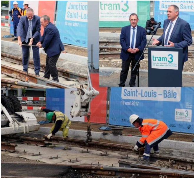
Oben rechts Alain Girny (l) und Hanspeter Wessels (r) Die letzte Schiene (ohne goldigen Nagel) wird eingebaut
