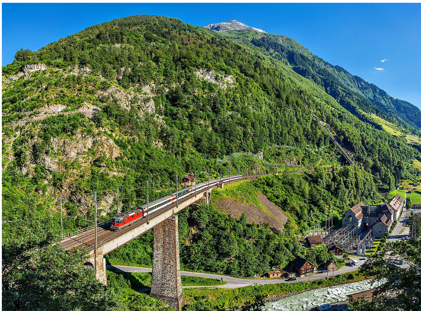
Das Kraftwerk Amsteg war bei der Inbetriebnahme 1922 das grösste Kraftwerk der Schweiz. Die monumentalen Gebäude in neubarockem Stil wurden vom Architekten Theodor Nager geplant und aus Gurtner Granit gebaut. Das Kraftwerk wird vom Chärstelenbachviadukt und von der 166 Meter langen Druckleitung eingerahmt. Bild: SBB
