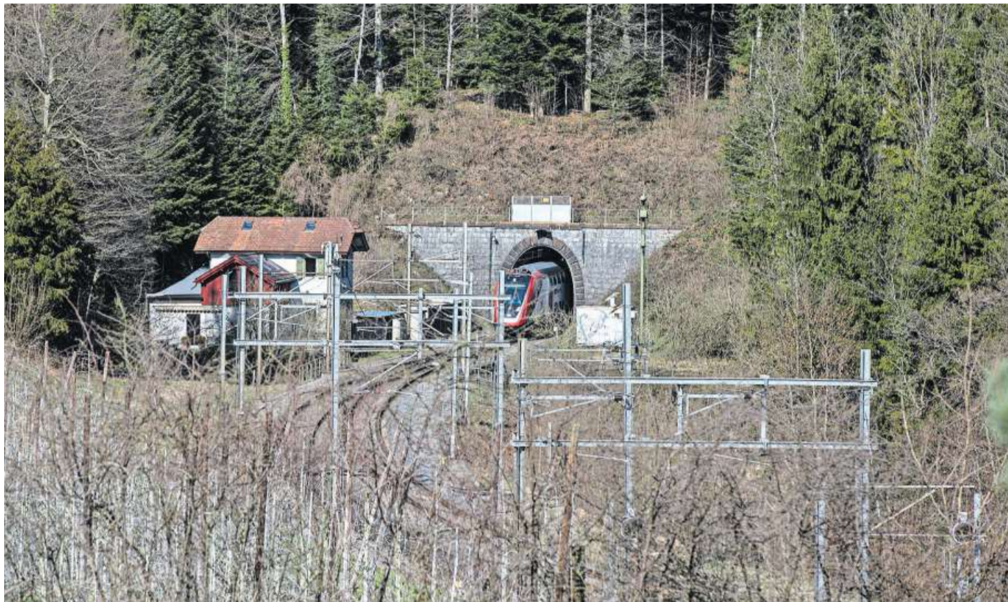
Das neue Portal des Zimmerbergtunnels wird links oder rechts des bisherigen (im Bild) entstehen.
