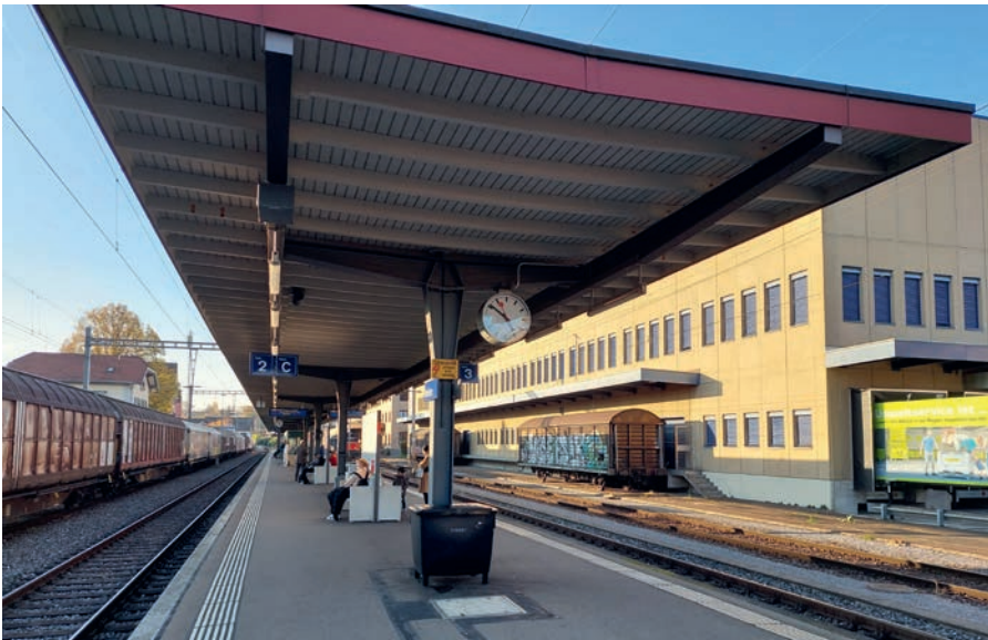
Würde sich für Solarzellen eignen: Perron-Dach in Meilen.
