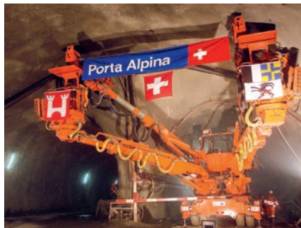
Bleibt eine Utopie: Erste Sprengung für die Porta Alpina in der GBT-Oströhre bei Sedrun im Jahr 2006. Bild: AlpTransit Gotthard AG
