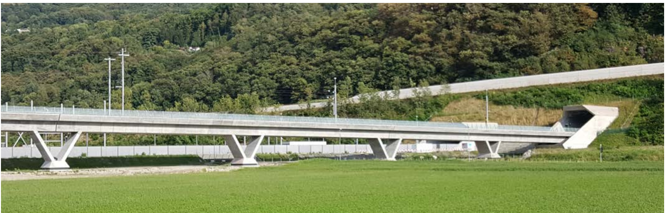
Ein eleganter Viadukt verbindet die Weströhre des CBT bei Camorino mit der Stammstrecke.
