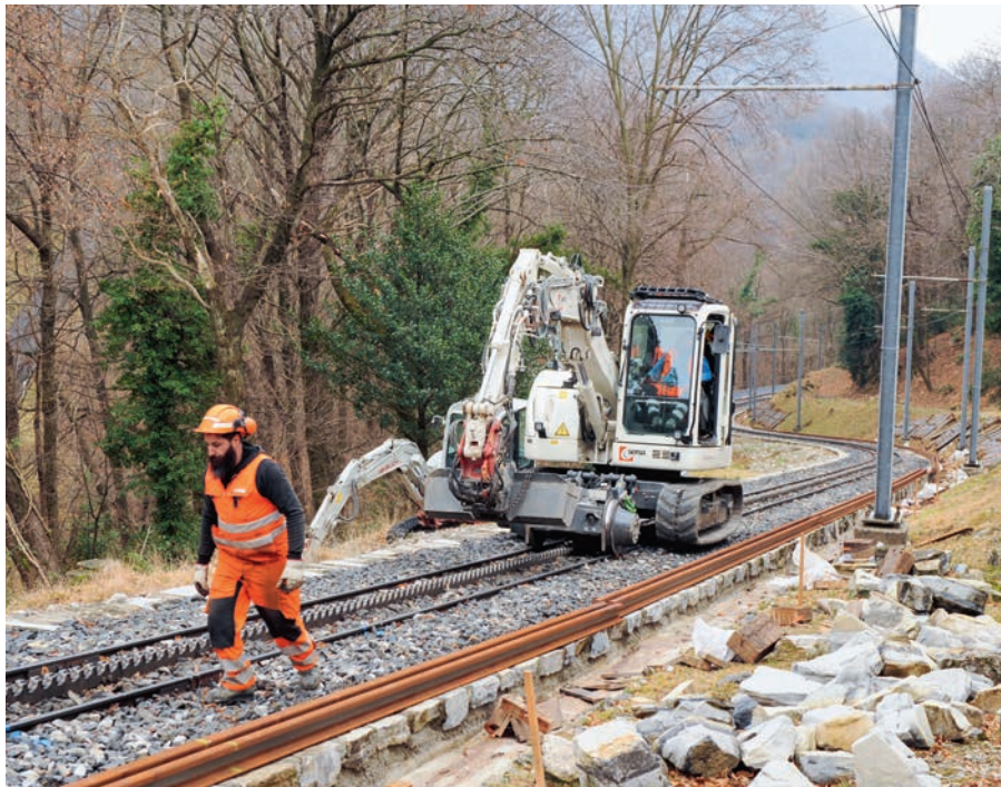
Ferrovia Monte Generoso: Nach 130 Jahren muss der Oberbau erneuert werden.
