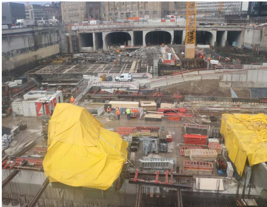
Gigantische Baustelle für den neuen Durchgangsbahnhof in Stuttgart.
