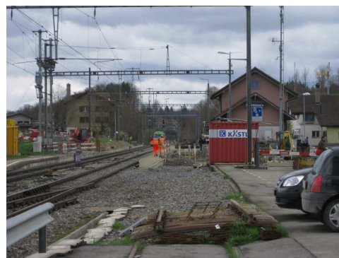
Ausbau Bahnhof Rosshäusern
