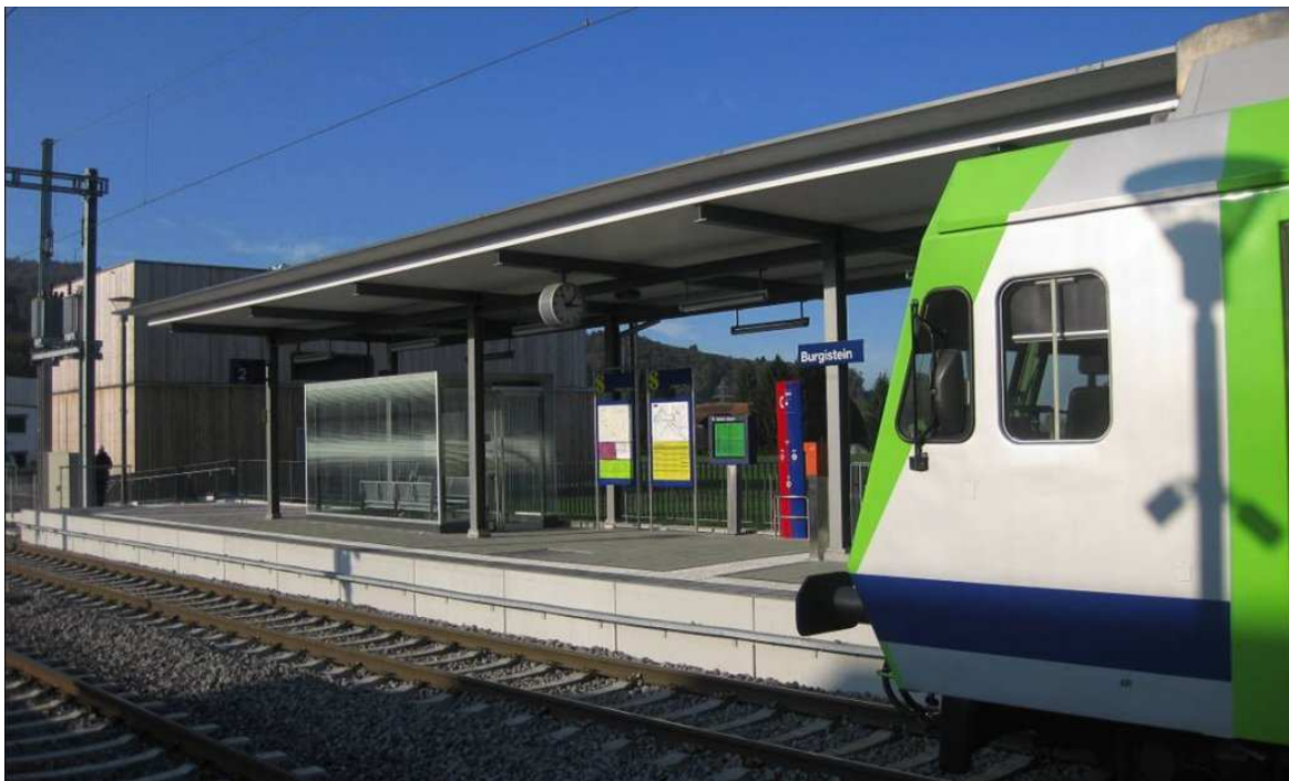
Aussenperron Seite Bern mit Technikgebäude im Hintergrund
